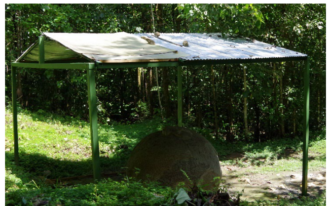
Año 2019 – Proceso de instalación de zinc
