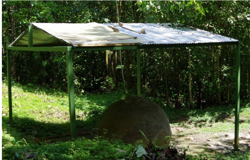
Año 2019 – Proceso de instalación de zinc
