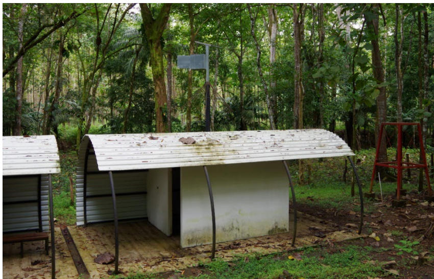
Escampadero construido en el Sitio El Silencio
