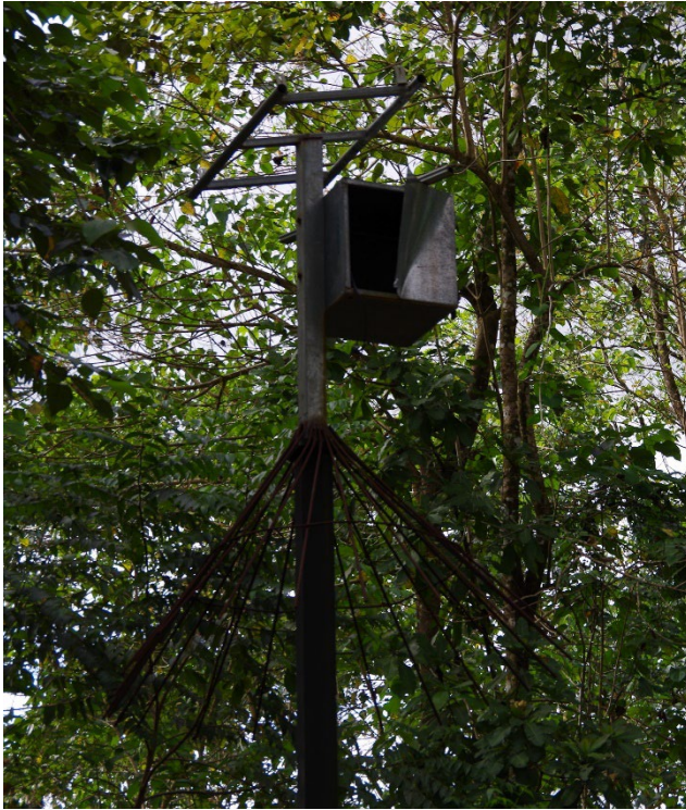
Restos de la instalación del panel solar
