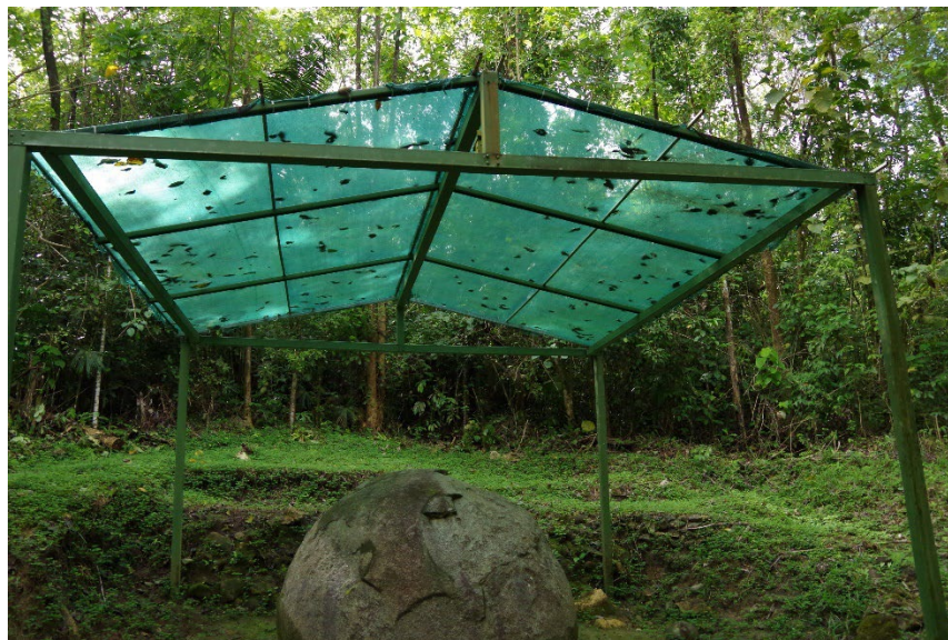
Año 2023 – Protección temporal a causa del vandalismo
